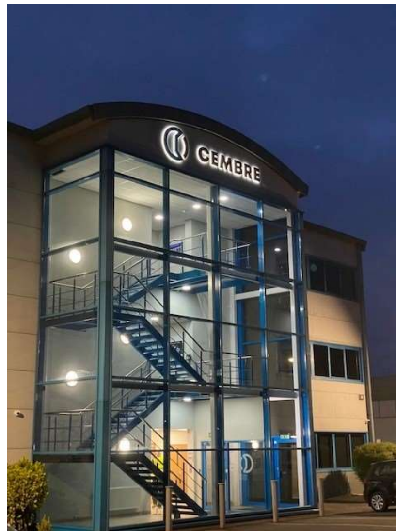
CEMBRE Ltd. – Stabilimento a Curdworth Birmingham (UK)
